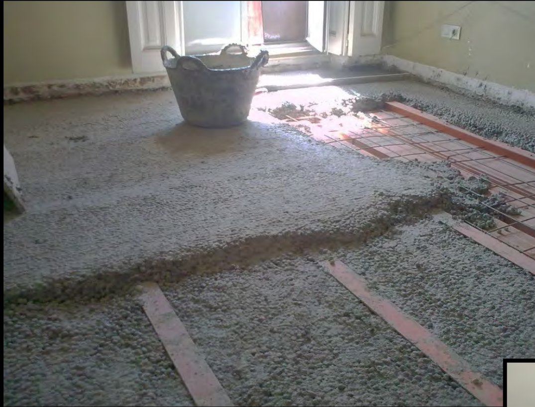
Hormigón ligero con autonivelante de bajo espesor para disminuir la rugosidad
